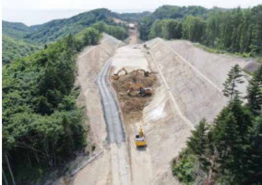
写真5 整備区間内には大規模な切土を行った場所も
