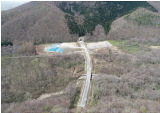
写真3 写真奥が水松沢(おんこのさわ)トンネル
