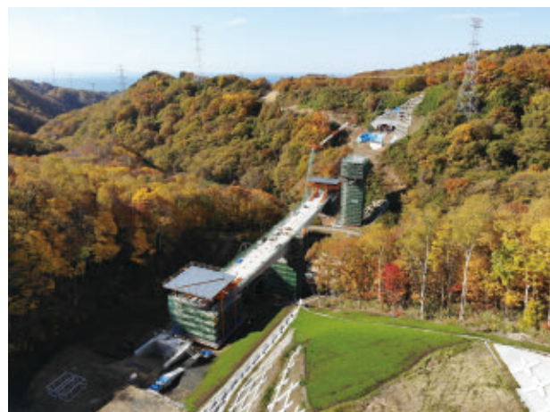
写真2 共和線内で最大の橋梁、全長230mの茶津大橋建設風景
