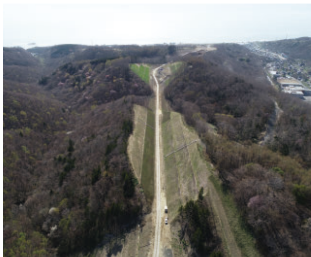
写真1 泊村茅沼地区を整備中の泊共和線
