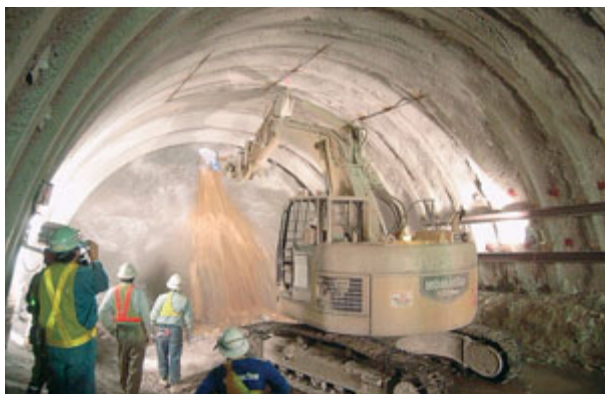
金八トンネル掘削工事状況
