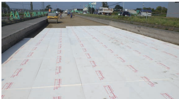
写真3 断熱材の設置の様子(岩見沢市)
