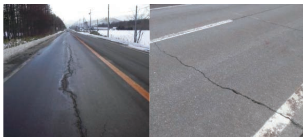
写真1 凍上による舗装のひび割れ 左:アスファルト舗装、右:コンクリート舗装
