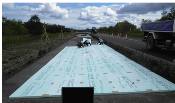
写真2 断熱材の設置の様子(苫小牧寒地試験道路)
