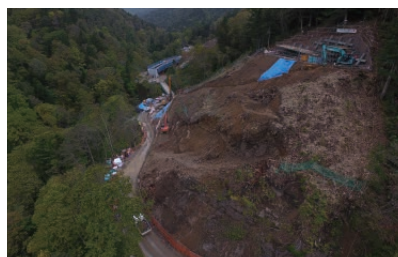
写真4 地滑り対策工事は、全長380m全4段にも及んだ
