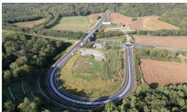
写真4 綺麗に整備された音中道路の音威子府IC
