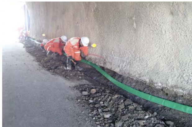
写真6 日浦4号トンネルの復旧作業の様子。排水路を舗装の下に埋め込むことで幅員を確保している
