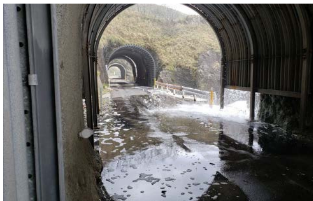
写真5 越波した海水がトンネル内に流れ込む
