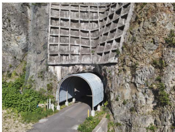
写真7 日浦1号トンネル。オーバーハング部の節理の露見や落石など防災上のリスクに対して、対策を進めている
