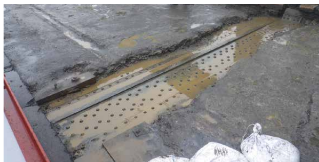
写真6 アスファルトの下から発見されたスライド型の伸縮装置
