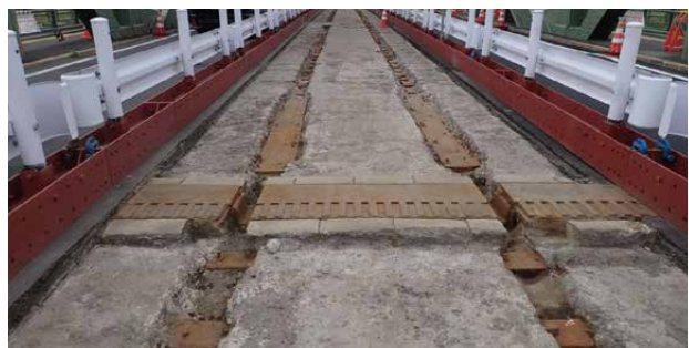
写真7 発見された路面電車跡と鋼製の枕木
