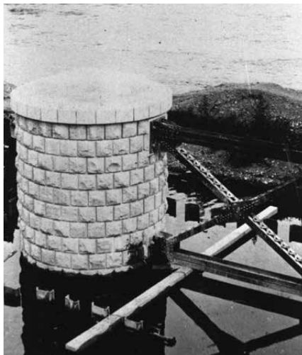
写真4 完成した橋脚。現在も当時の姿を残している
