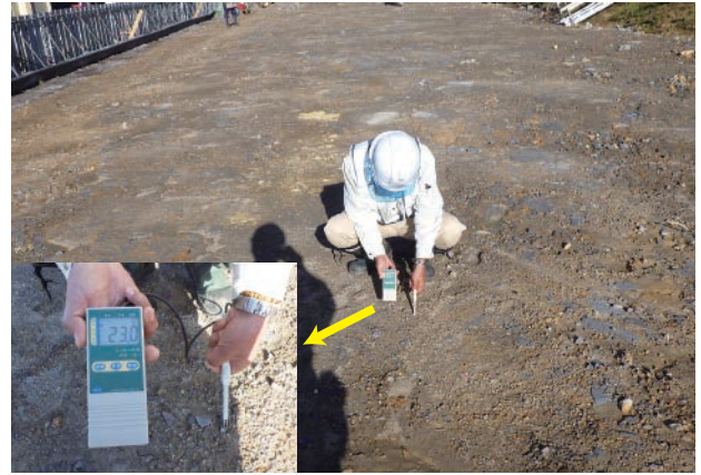
写真1 盛土の含水比計測の状況
