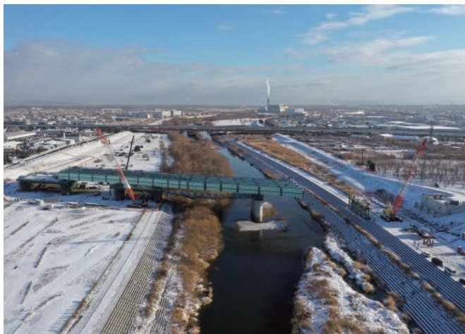
写真2 送り出し工法による東区側からの架設の様子
