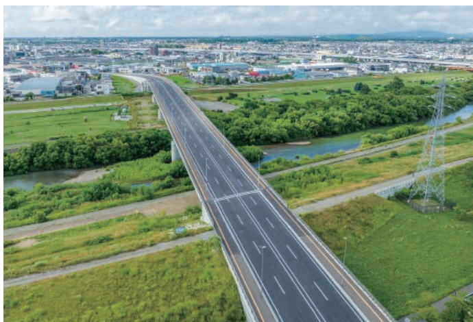
写真1 北24条桜大橋。写真の奥側が東区、手前側が白石区
