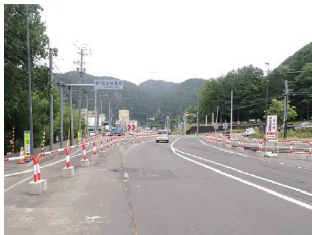
写真2 工事中の様子。交通を遮断することのないよう、切り替えなど工夫しながら実施
