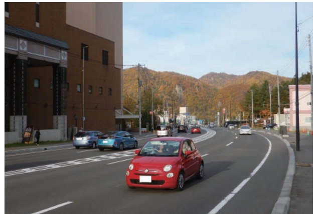
写真5 住宅や店舗の出入りに配慮して採用した、ゼブラ区画線の中央分離帯
