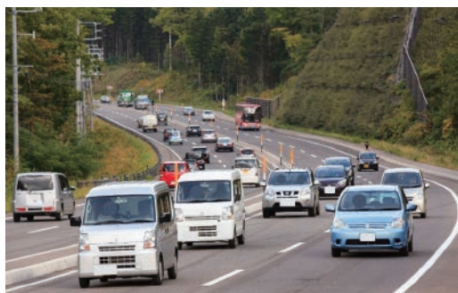
写真4 小金湯拡幅事業 整備後の様子
