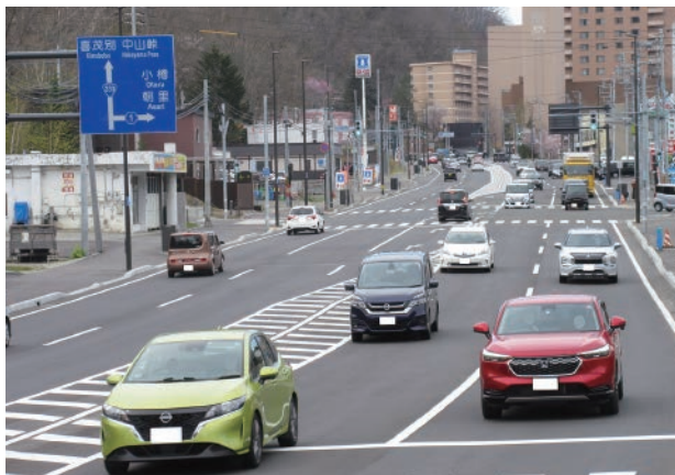
写真3 4車線化後の定山溪温泉街。右折レーンも設けられ、渋滞はかなり緩和
