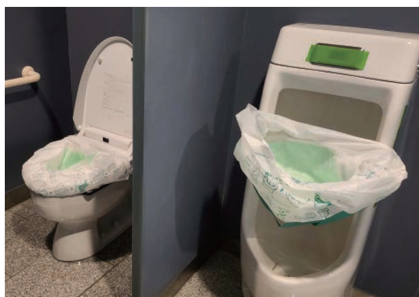
写真1 既存のトイレに設営した携帯トイレ(大・小用)
