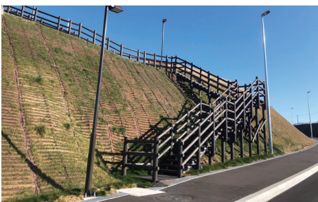
写真3 庁舎のエントランスへと続く避難階段
