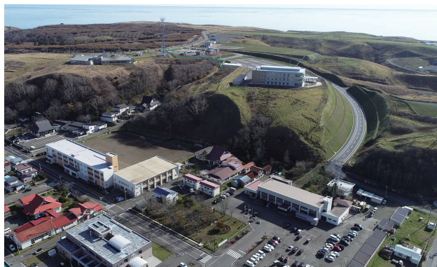
写真1 湯沸高台避難道路
