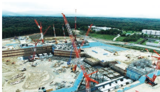
写真1 工事が始まったFビレッジの様子(2020年8月撮影)
