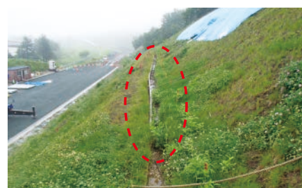
写真1 法面変状(トラフのズレ・沈下、法面の波打ち) (平成30年7月3日)
