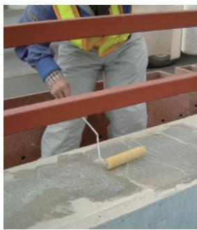
写真4 地覆へのシラン系表面含浸材塗布
