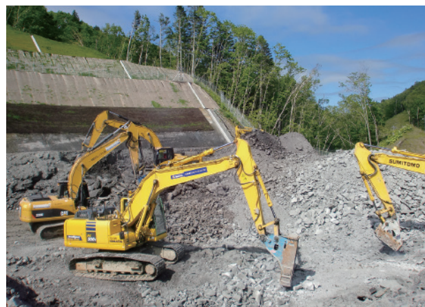
写真1 硬い岩盤掘削の様子
