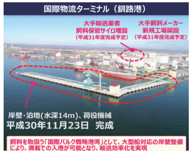
写真2 釧路港の国際物流ターミナル
