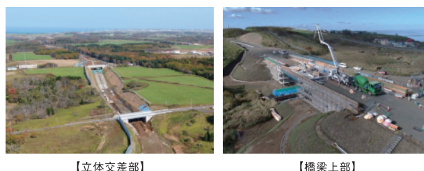
写真5 根室道路の施工状況
