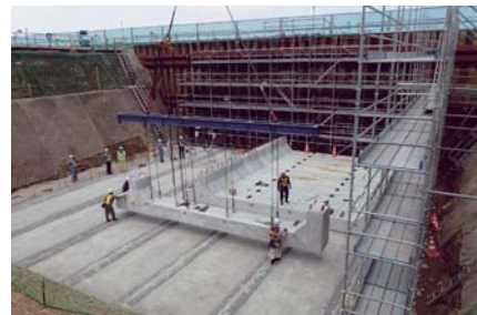
写真1 銭函IC函渠組立状況
