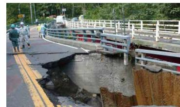
写真1 国道453号奥漁川橋の損傷
