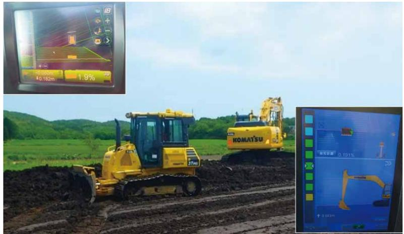
写真1 ICT施工の状況（操縦席のモニターに施工位置が示される）
