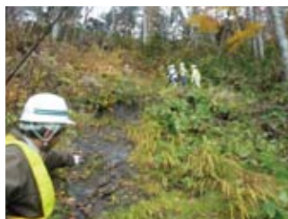
写真-1 崩壊現場の踏査状況
