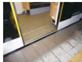
停留場と新型低床車両乗車口の段差
