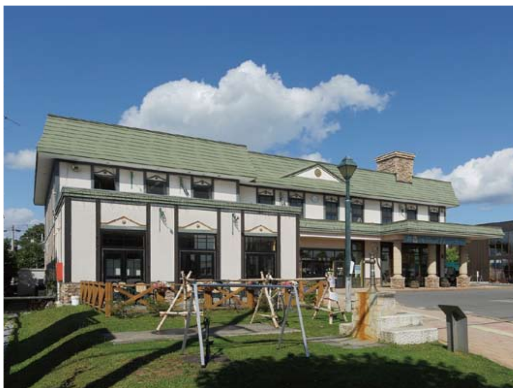
道の駅「ひがしかわ『道草館』」
