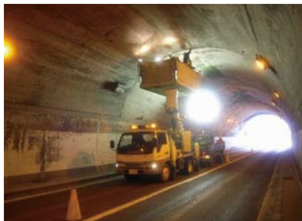
写真2 トンネル点検
