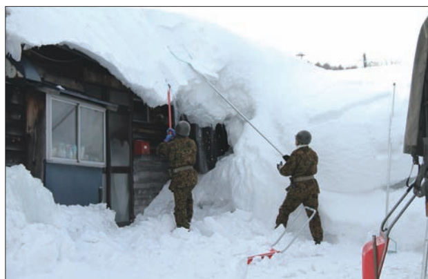
▲ 美流渡地区 自衛隊による雪下ろし作業
