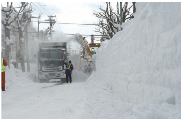
▲バス道路の排雪状況
