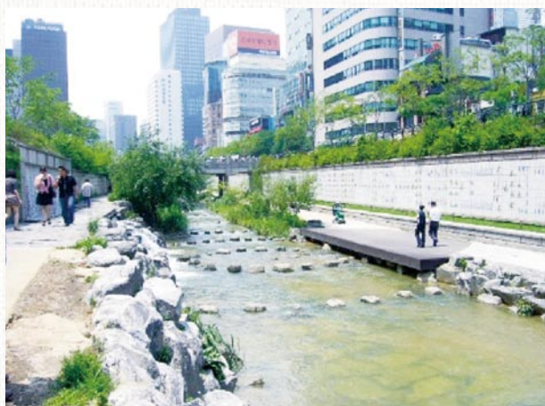
写真14 観水橋(ファンズギョ)周辺の散策路 (河川は近自然工法で整備されているが、全体は、3~4mの壁面に覆われている)
