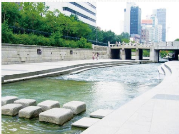
写真11 広通橋(クアントンギョ)を望む河川デザインの様子 (中心部の再生箇所の多くは、3面張りの構造となっている)
