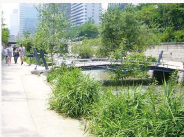
写真12 人道橋の水標橋(スピョギョ)の状況
