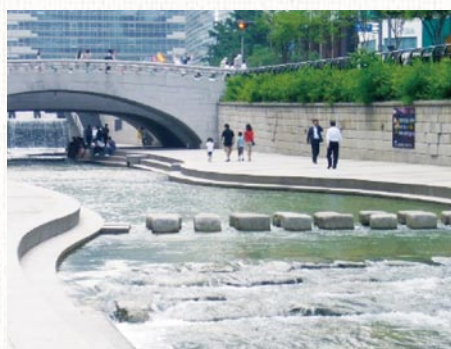
写真9 毛塵橋(モジョンギョ)周辺の河川整備状況 (コンクリートと石材による構成になっている)
