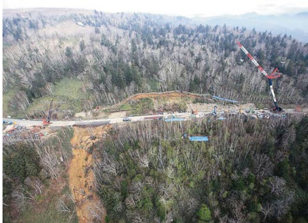
現地調査、復旧工事の状況
