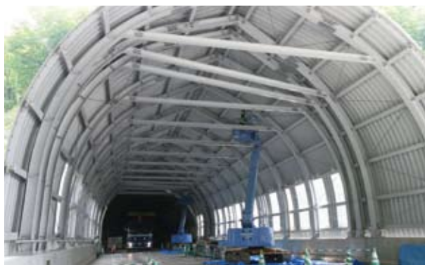
写真5 大夕張トンネルのスノーシェルター工事の様子
