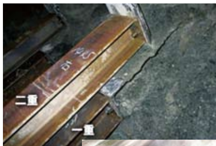
写真2 高強度二重支保工 の施工状況
