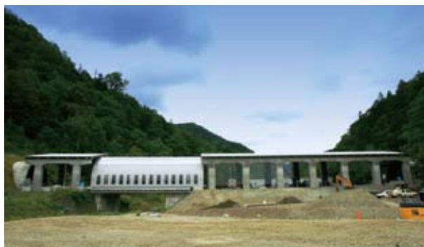
写真6 長和トンネルと穂別トンネル間のスノーシェッド・シェルター工事の様子
