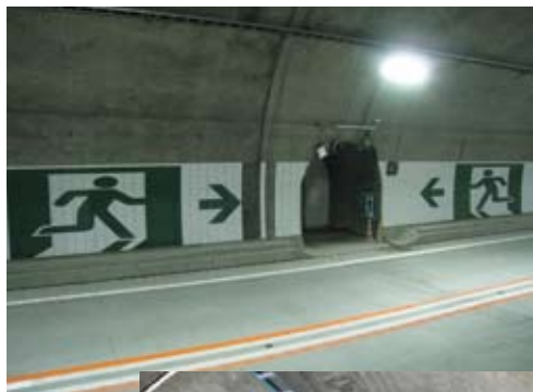
写真7 穂別トンネル 内にある避難 用トンネルへ の入口
