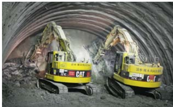
写真4 穂別トンネル内での掘削作業
