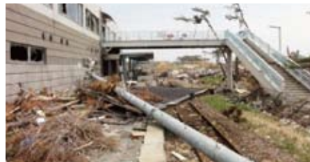
写真2 2階建の屋根まで津波が達していた道の駅大谷海岸の被災状況
