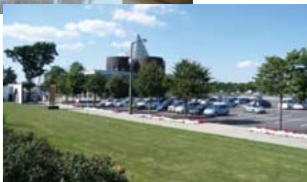
写真9 広い園地や緑は、特に夏期における災害時に様々な活用が可能となる
