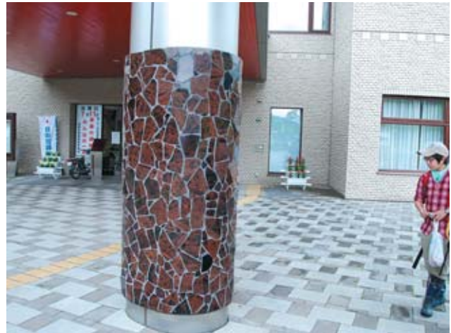
玄関前の柱は白滝黒曜石（「花十勝」）のタイルで装飾されている
