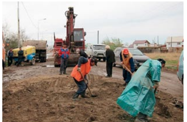
写真－7 道路改修作業(ヤクーツク市郊外)
