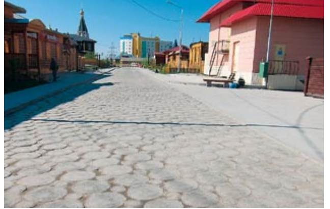
写真－5 旧市街の木製の舗装(ヤクーツク市内)
