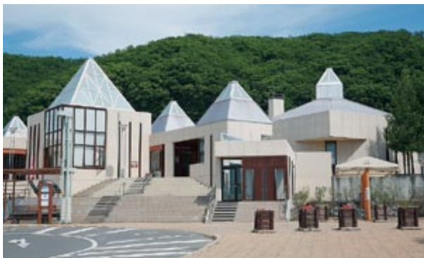
道の駅「ステラ★ほんべつ」外観
