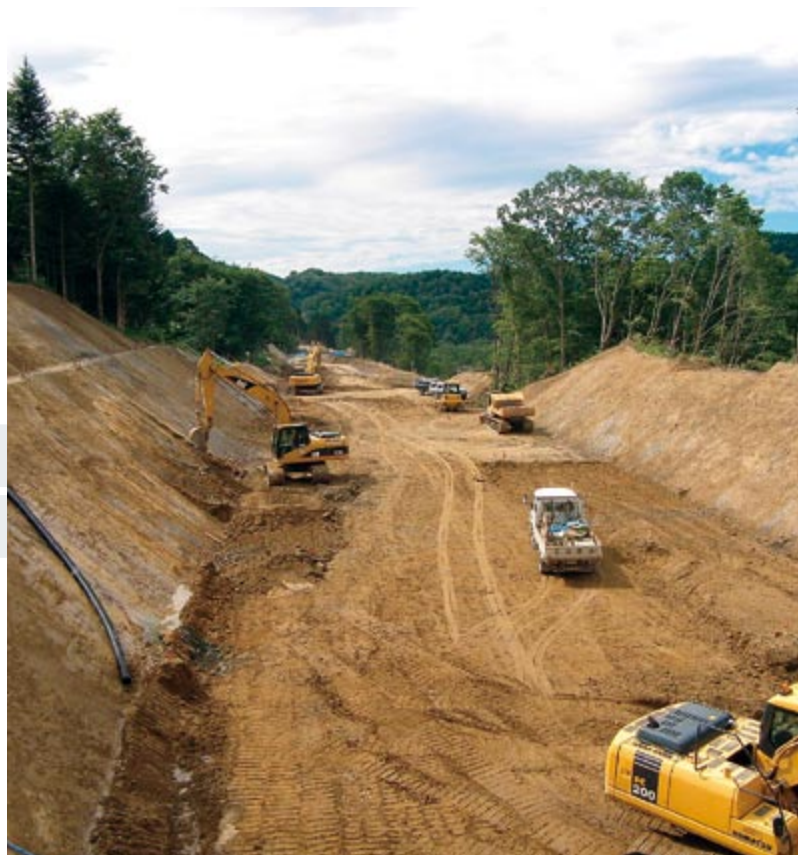
付替工事中の道道当別浜益港線
