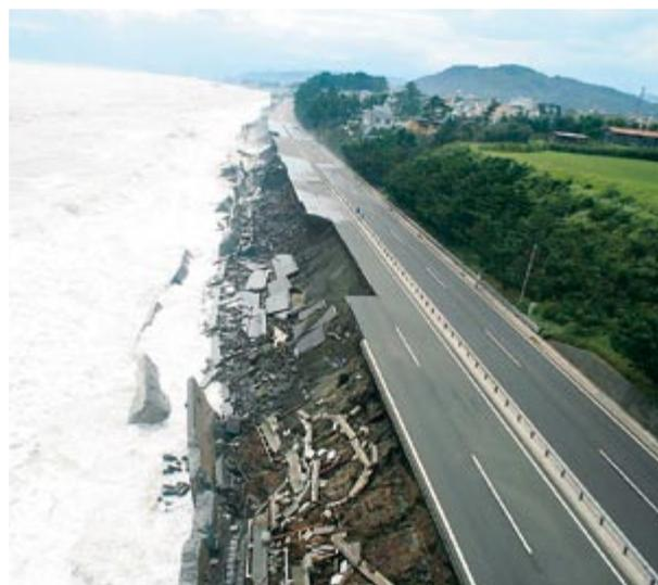
写真-2 西湘BPの崩壊（平成19年9月7日撮影）
