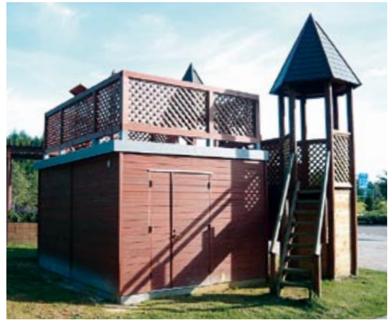
展望台にもなっている蓄電池室
