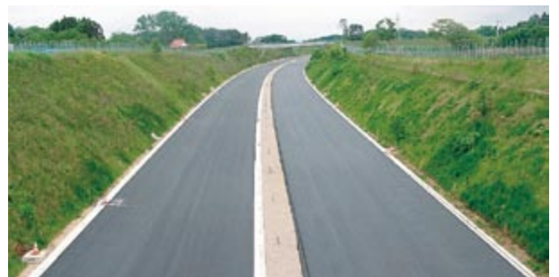
道央道八雲町熱田付近から函館方面(4車区間)
