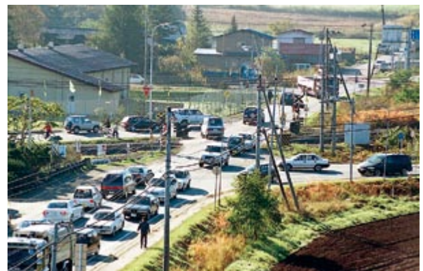
工事前の渋滞発生の様子
