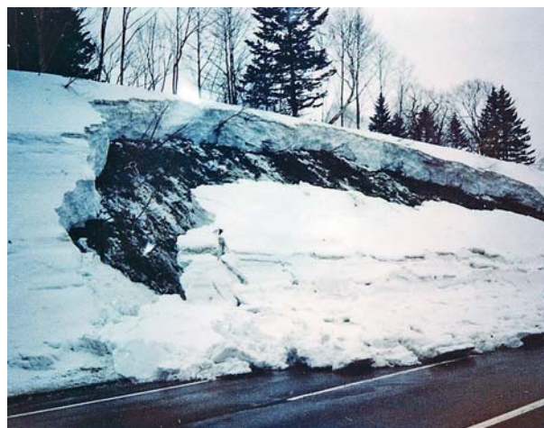
写真4 切土法面で発生した面発生湿雪全層雪崩
