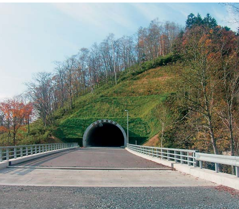
図2 「歌登トンネル」 枝幸側坑口
