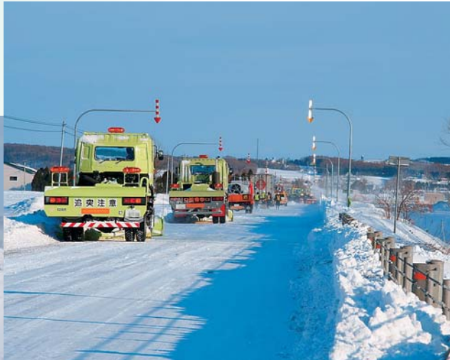
国道274号 除雪作業の様子
