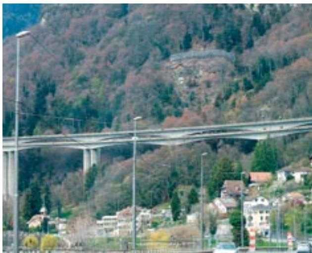
写真-3 シオン高架橋の上に見える落石対策
