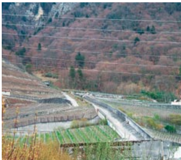
写真-4 土石流対策(N9を跨ぐ土石流流路工と葡萄畑)
