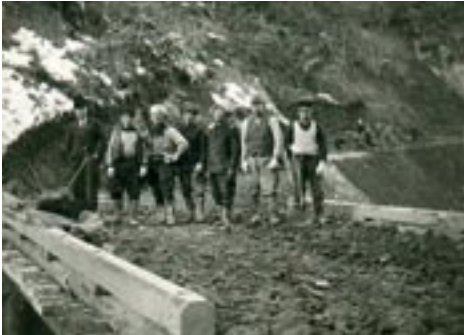
写真1 補修作業完了時(?)の記念写真(撮影年不明)
