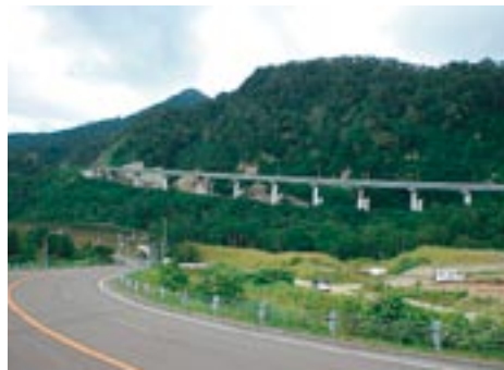
写真9 雪崩を跨いで避けた大雪崩橋
