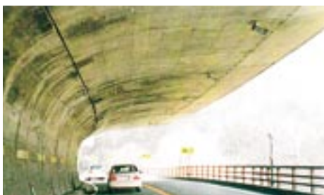
写真3 谷側に柱のない仙境覆道
