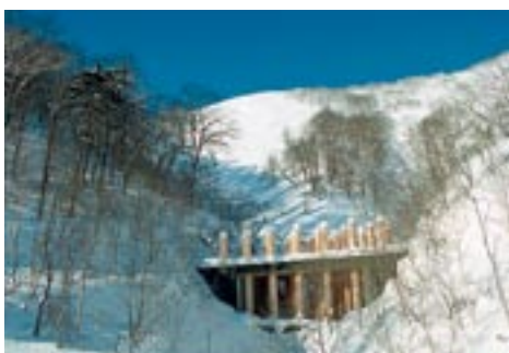
写真6 杭減勢工で止めきれない雪崩は道路までの堆雪スペースに収める
