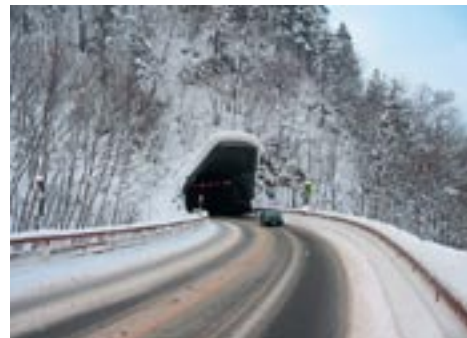
写真4 トンネル坑口の雪崩、落雪・落石を防ぐ庇
