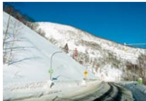
写真5 斜面全体に設置された雪崩予防柵
