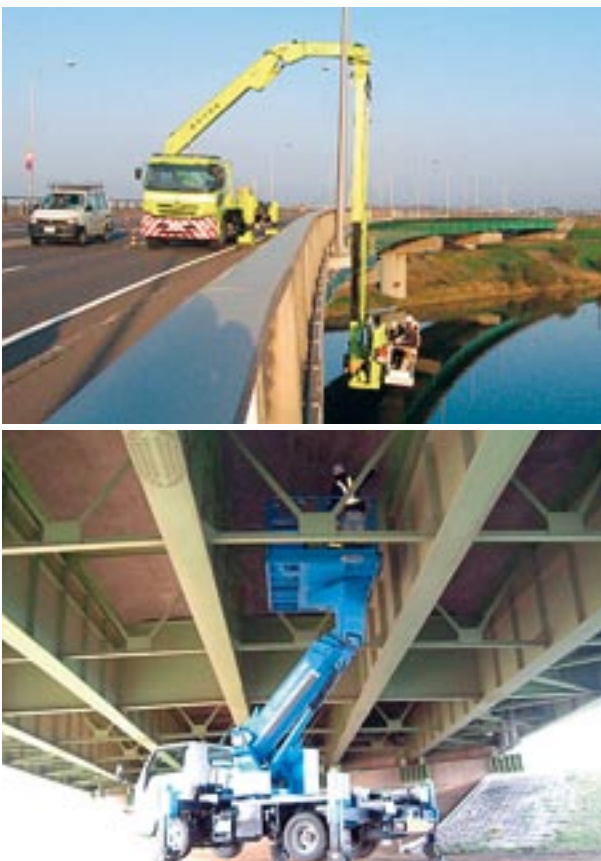
写真－2 橋梁点検の様子
