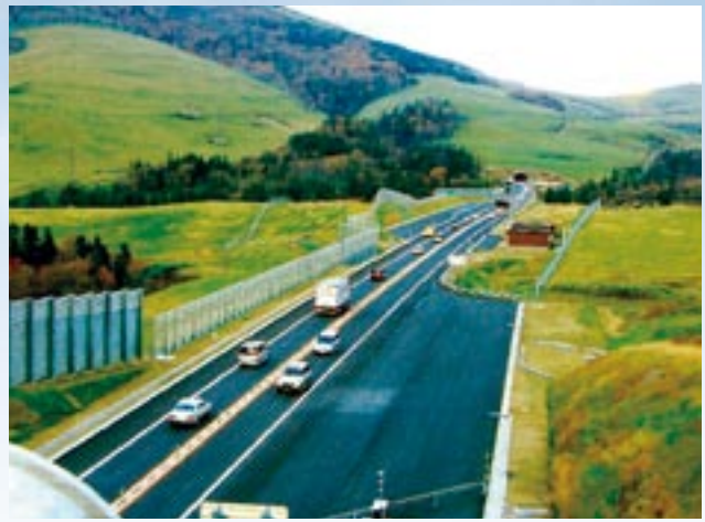
開通後の週末状況（南富良野町串内地区）
