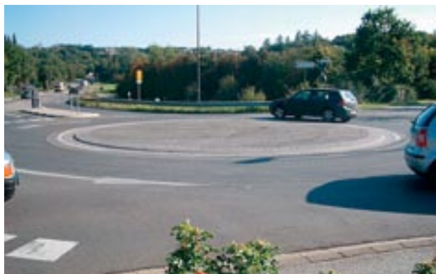
写真-2 ミニラウンドアバウトの例(バート・クロイツナハ道路事務所管内)
