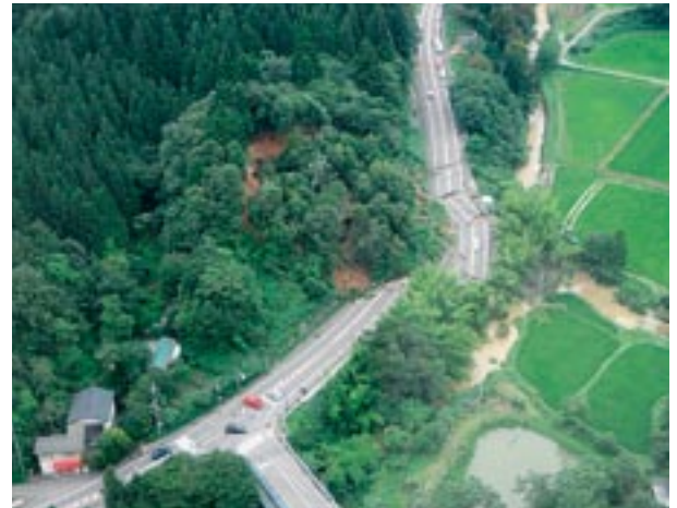
7月11日の新潟県中越地震の被災状況（R8号）
