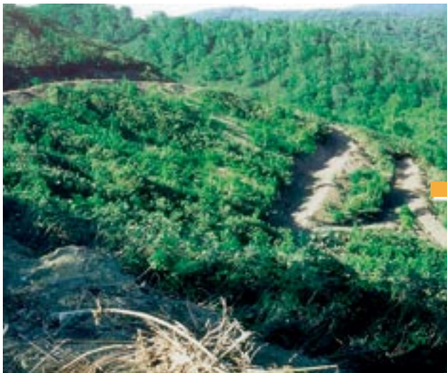
写真-3 階段工施工直後の、1993年の山腹斜面
