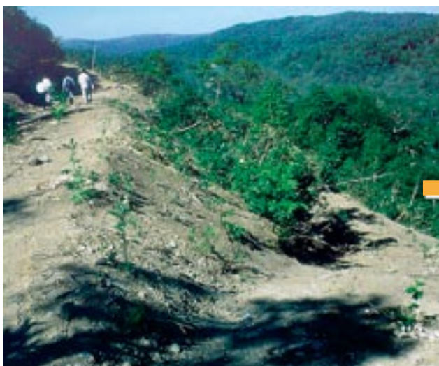
写真-5 1993年、試験施工直後の階段工部分
