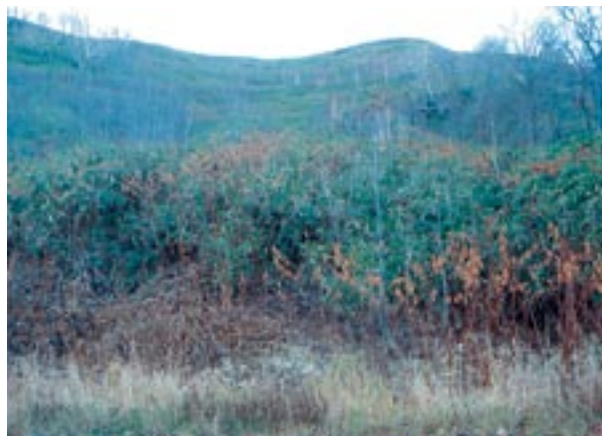
写真-7 2006年10月、路側から見た試験施工斜面の13年後
