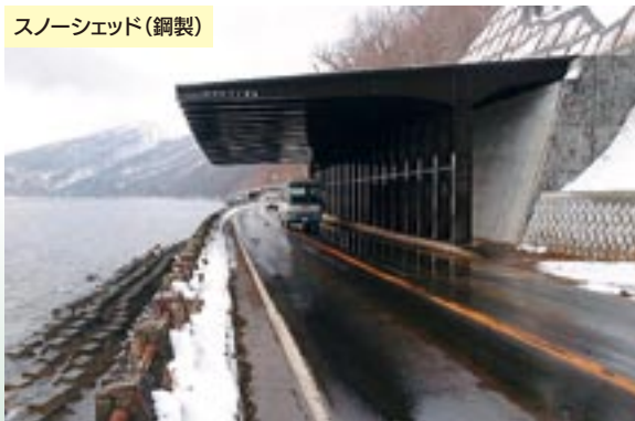
写真-1~3 雪崩対策(ハード対策)
