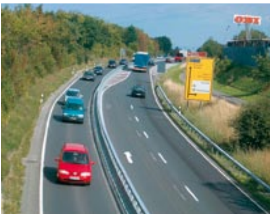
写真-1 2+1車線道路(国道262号)
