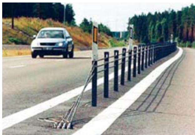
写真-2 中央分離帯としてケーブル防護柵を設置(2+1車線道路;スウェーデン)(文献2より転載)
