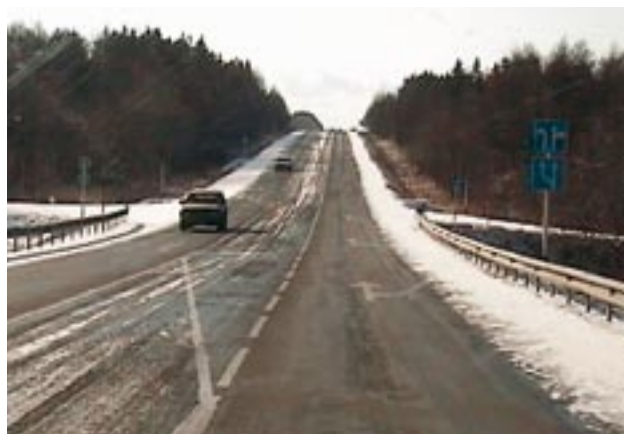
写真-3 2+1車線道路(国道488号)
