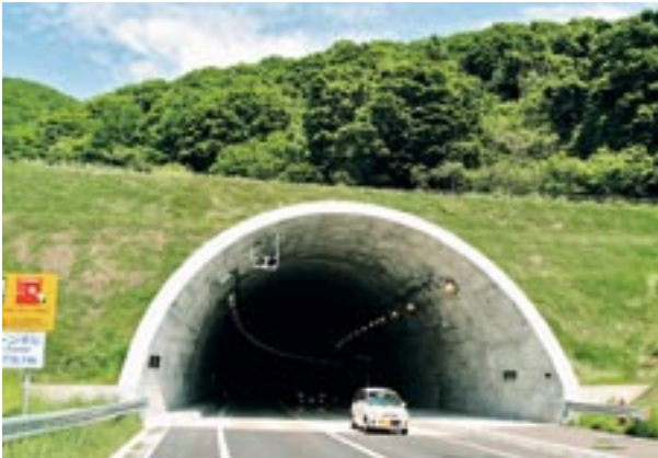
全長1,719mの青葉トンネル
