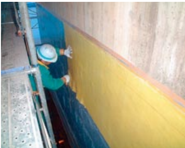
図4 シート貼り付け状況
