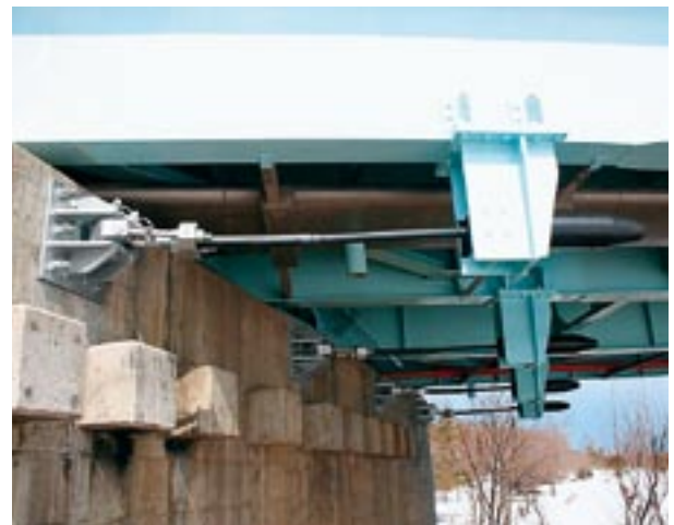
図7 PCケーブルによる落橋防止構造
